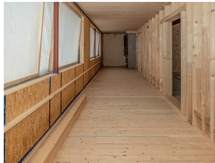
Innen und außen alles aus Holz: Der Landkreis Fulda baut in Poppenhausen das erste Mal ein Schulgebäude aus Holz.
