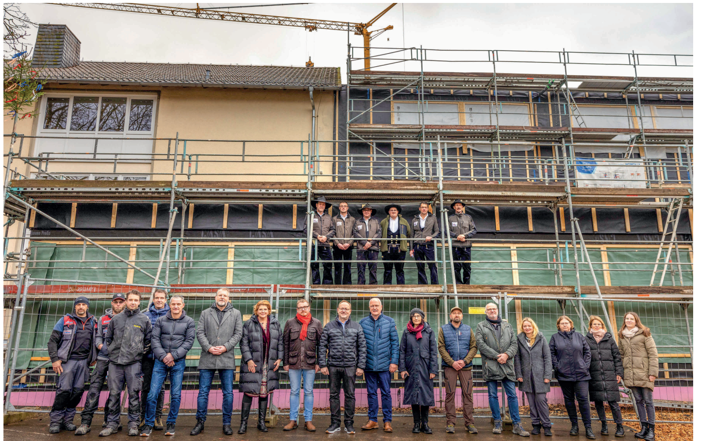
Es geht voran: Beim Erweiterungsbau der Grundschule Poppenhausen wurde Richtfest gefeiert. Der Anbau besteht auf drei Geschossen komplett aus Holz. Den Richtspruch hielten die Zimmerer des Unternehmens Schneck. Fotos: Sebastian Mannert
